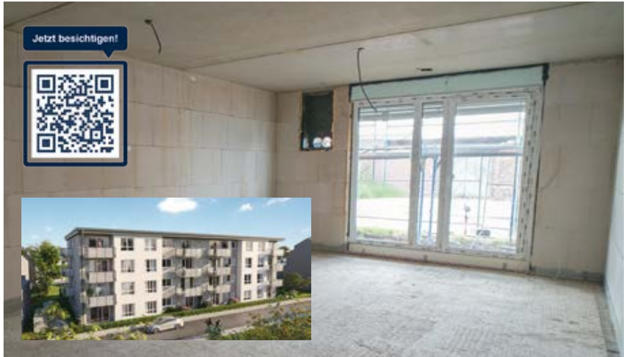
Neubauprojekt in Dormagen Mitte: Der Rohbau des Neubauprojekts Höhenberg IV-VI ist fertiggestellt, die Baustelle ist nun für Besichtigungen geöffnet. Realisiert werden insgesamt 24 Eigentumswohnungen.
